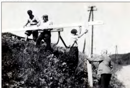
Budowa bocznicy kolejowej przy Spółdzielni w Tymbarku, prace nadzoruje inż. A. Parzyński; fot. ze zbiorów Muzeum Regionalnego Ziemi Limanowskiej.
