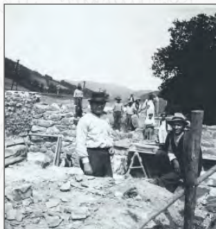
Inżynier Józef Marek przy budowie przechowalni owoców; fot. ze zbiorów Muzeum Regionalnego Ziemi Limanowskiej.
