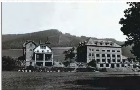
Z lewej strony budynek przechowalni, wzniesiony w latach 1937-1938; po prawej główny budynek przetwórstwa wybudowany w latach 1940-1941; fot. ze zbiorów Muzeum Regionalnego Ziemi Limanowskiej.
