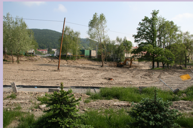
Teren w trakcie realizacji inwestycji
