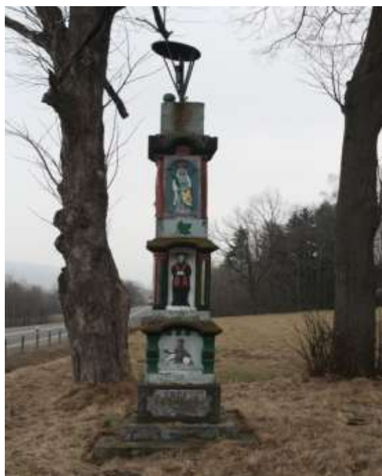
Kapliczka w Podłopieniu, stan przed remontem
