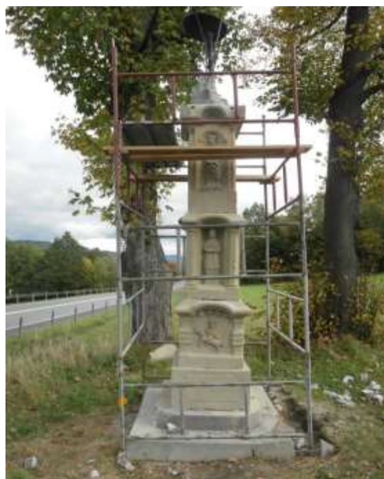
Kapliczka w Podłopieniu, stan po I etapie remontu
